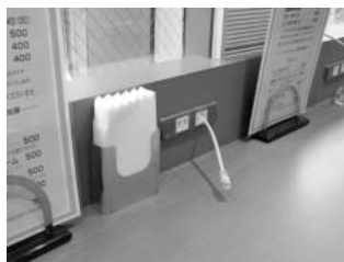
カウンター席の電源とイーサネット。1席ごとに電源ソケットが用意されている。
