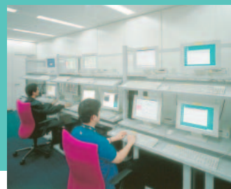
大手町の運用監視センター
