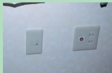
すべての部屋には電源コンセントと並んでイーサネットの口がある。
