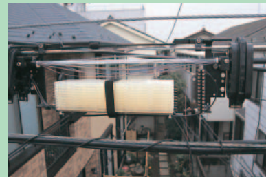
架設されている200芯の光ファイバーから2組を取り出し、加入者宅へのファイバーへと接続する。
