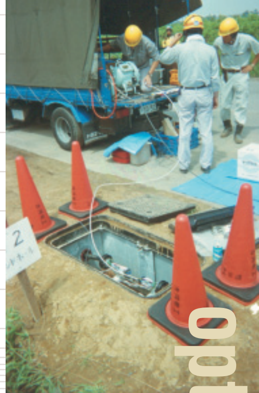
ユニット送通の作業の様子。トラックの荷台に乗せられているのが送通のための機器。非常にコンパクトである。
