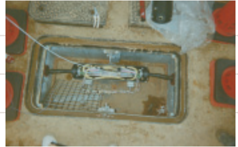
機器が小さいためマンホールやハンドホールなど狭い作業空間でも容易に施工できる。写真はハンドホール内の接続クロージャを開け、送通のためのパイプを接続した状態。
