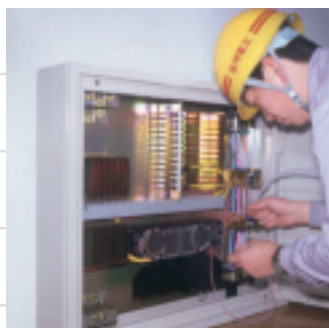
ビル内の接続ボックスにユニットが顔を出したところ。つまみ出しさえすればよい。
