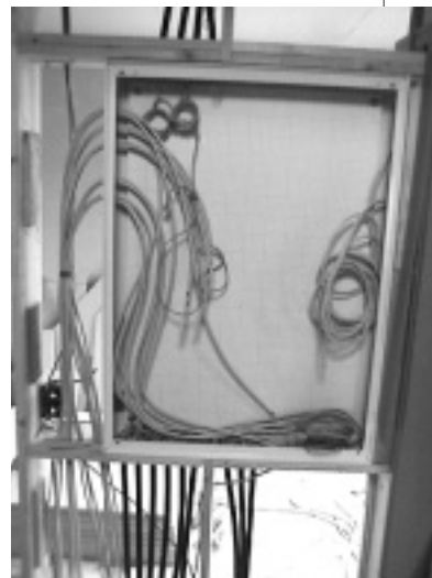
この中にブースター、分配器、モデム、ハブ、DSUなどが入る。
