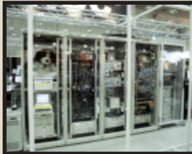
●ギガスイッチが並ぶNOC内のPOD (左) とベイ・ネットワークス社の「Accelar1250」
