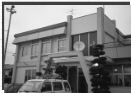
伊那xDSL利用実験（長野県伊那市）
